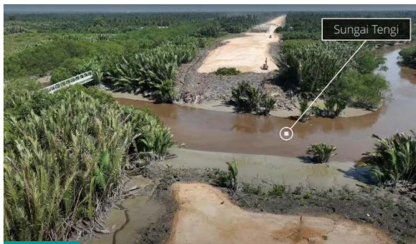
Kerja Tanah dan 'Site Clearing' bagi Lebuhraya WCE merentasi Sungai Tenggi
