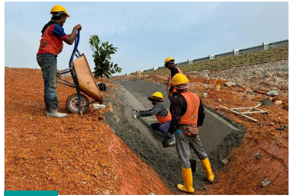
Penyediaan kotak acuan untuk pembinaan 'wingwall' di KM 117.4 arah barat Preparation of mould box for wingwall construction at KM 117.4 westbound
