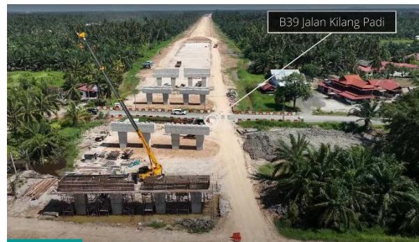
Pembinaan jambatan merentasi Jalan Kilang Padi
