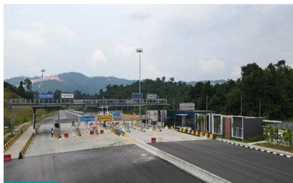
Plaza Tol di Bandar Mahkota Cheras Toll Plaza at Bandar Mahkota Cheras
