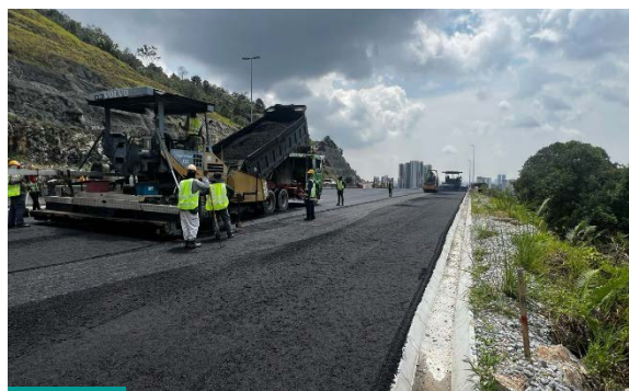
Ch 540 - Ch 830 (LHS) Ch 540 - Ch 830 (LHS)
