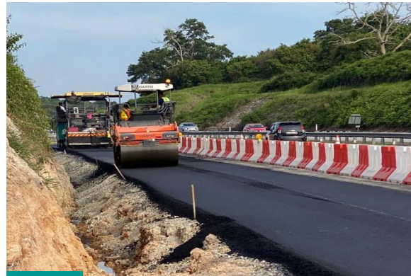
Turapan ACWC untuk lencongan sementara di KM 118.3 arah timur ACWC pavement for temporary diversion at KM 118.3 eastbound
