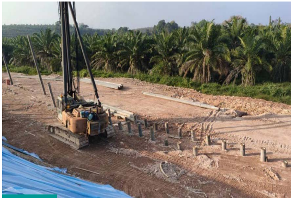
Penanaman cerucuk untuk pembaikan cerun di KM 117.8 arah timur Planting of piles for slope repair at KM 117.8 eastbound
