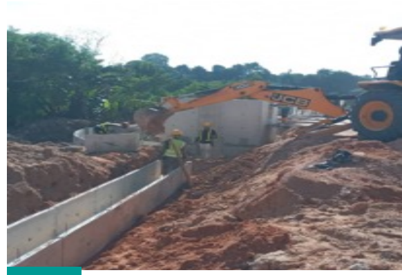
Jambatan BR 21 / Jalan Susur Ampang: Pemasangan longkang jenis RUD 600 untuk disambungkan ke sump. BR 21 Bridge / Jalan Susur Ampang: Installation of a RUD 600 type drain, to be connected to the sump.
