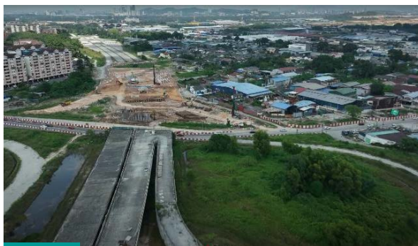
Pembinaan Persimpangan Sri Andalas
