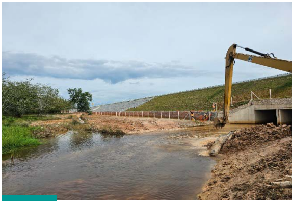
Kerja pemotongan untuk memastikan aras sesuai bagi pengaliran air di pintu masuk pementung di KM 123.5 arah timur Cutting work to ensure a suitable level for water flow at the sewer entrance at KM 123.5 eastbound
