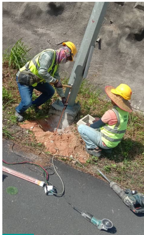
Kerja-kerja pemasangan kabel lampu jalan di Ampang. Street light cable installation work in Ampang.
