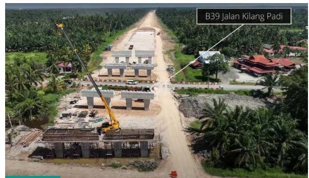
Pembinaan jambatan merentasi Jalan Kilang Padi
