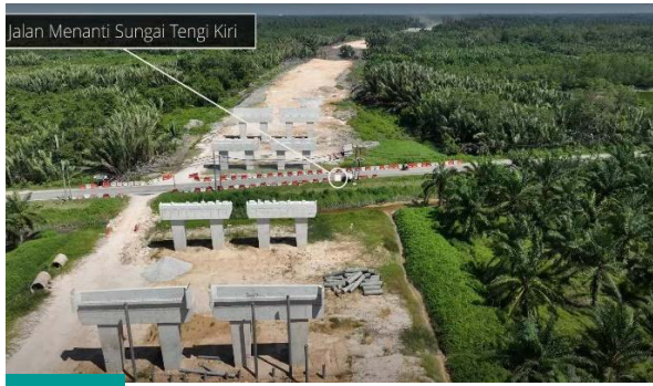
Pembinaan Jambatan Merentasi Jalan Menanti Sungai Tenggi Kiri
