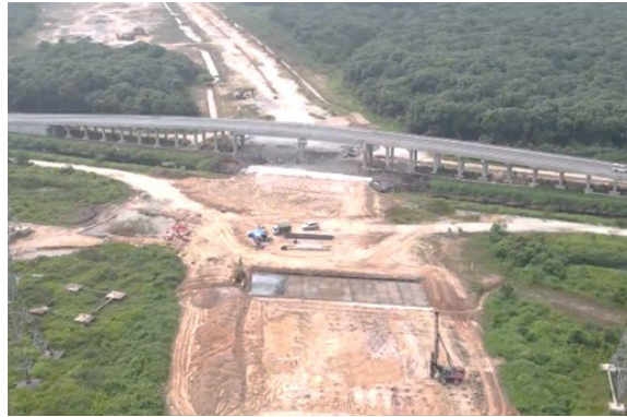
Pembinaan ROB Jalan Sijangkang Utama (Seksyen 2). ROB construction Jalan Sijangkang Utama (Section 2).
