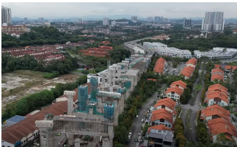
Persimpangan Bertingkat Alam Damai. Alam Damai Interchange.
