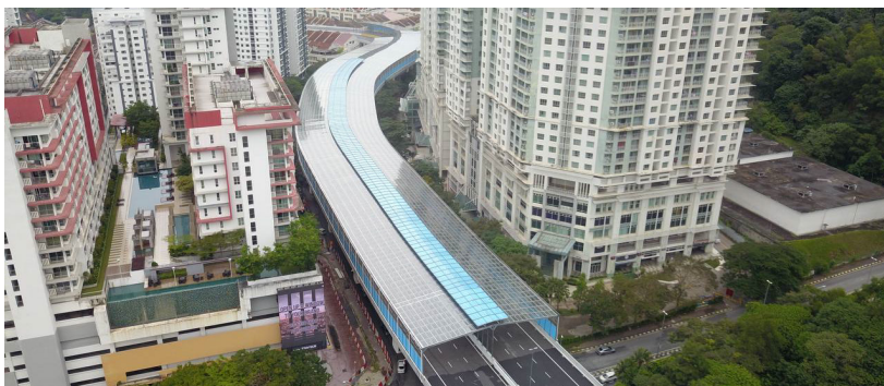
Penyerap bunyi kepungan penuh di Damansara Perdana
