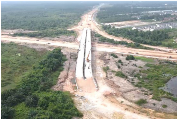
Pembinaan persimpangan SKVE (Seksyen 2). SKVE Intersection construction (Section 2).
