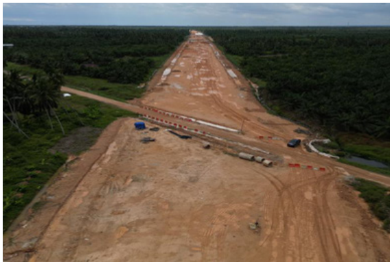
Pembinaan ROB di Seksyen 7 (Jalan Sg. Tunggul). Construction of ROB in Section 7 (Jalan Sg. Tunggul).
