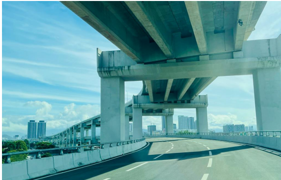
Jajaran struktur bertingkat double deck Lebuhraya SPE laluan utama dari Persimpangan Salak ke Jalan Kg. Pandan
