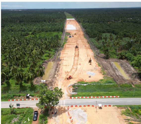
Pembinaan jejambat merentasi LPPB di Seksyen 7 (Jalan Gulang-gulang). Construction of a flyover across the WCE in Section 7 (Jalan Gulang-gulang).
