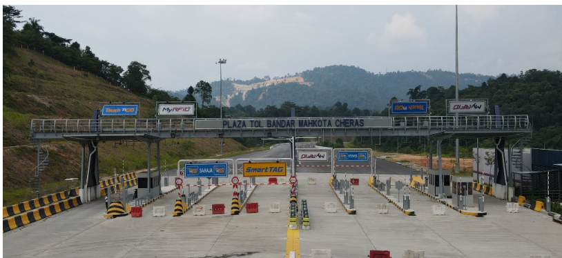
Plaza tol di Bandar Mahkota Cheras Toll plaza at Bandar Mahkota Cheras
